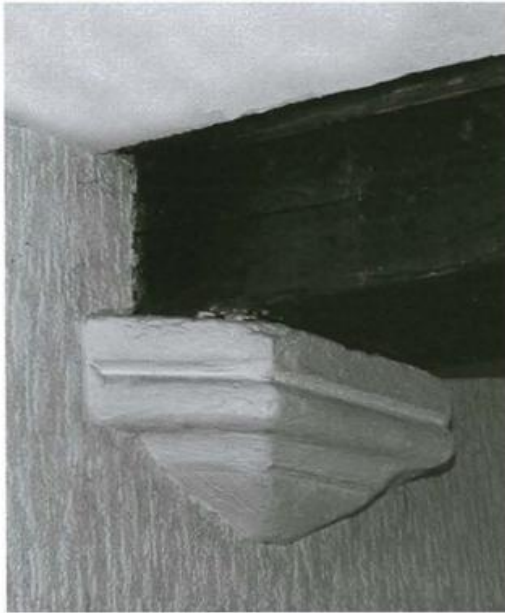
Links: geprofileerde impost met drie vlakken uit witte steen als drager van een zoldervloerbalk. Rechts: detail van een sobere, afgeronde impost.
