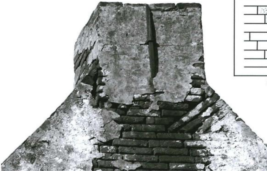
Klezorenverband in de westelijke gevel.
