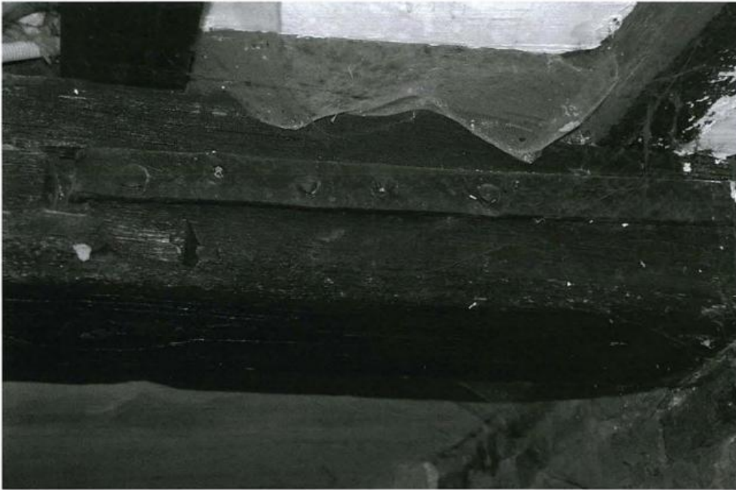
Links: bevestiging van een muuranker aan de balk van de zoldervloer. Rechts: muuranker in achtergevel, half verzonken in 19e-eeuwse cementbepleistering.
