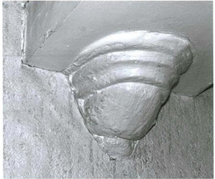
Links: geprofileerde impost met drie vlakken uit witte steen als drager van een zoldervloerbalk. Rechts: detail van een sobere, afgeronde impost.
