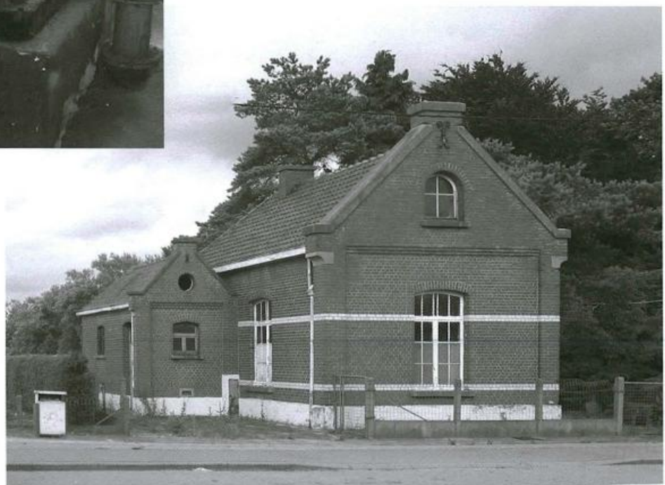
Foto van het pompstation anno 2008. Het bevindt zich op de Steenweg naar Alsemberg ter hoogte van de uitrit van de E19. Het kleine gebouwtje links is de elektriciteitscabine.
