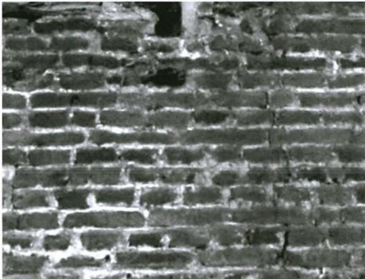
Standaardverband in de oostelijke gevel.
