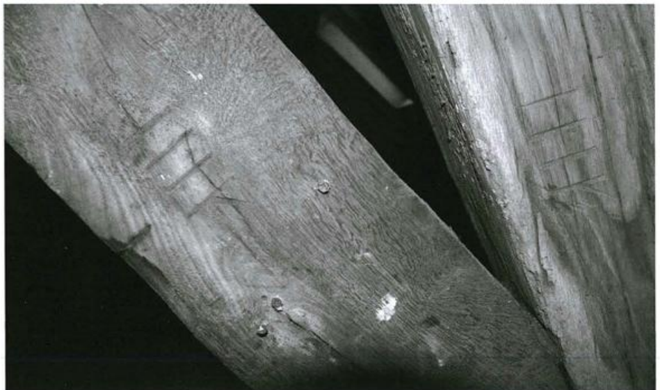
Detail van de nummering op het korbeel en spantbeen. Het schuine streepje aan de vierde I geeft aan dat deze onderdelen rechtsmoeten komen (in de Zwaan de zuidelijke achtergevel).
