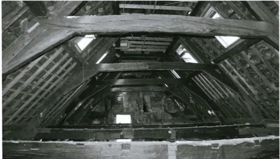
Op de eerste trekbal werd kubusvormige inkepingen gemaakt, mogelijk lag er vroeger op de trekbal een houten vloer als derde verdieping.
