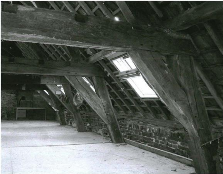
Het onderste van de spanten of dakstoelen: de vier spantbenen, rechts de bakstenen borstwering als bovenste van de zuidelijke achtergevel.
